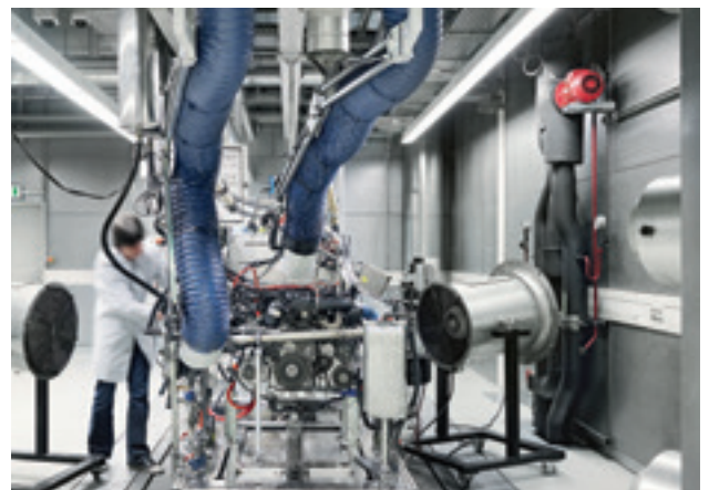
Rückgewinnung im Motorenprüfstand: Bei den Testläufen entsteht neue elektrische Energie.
