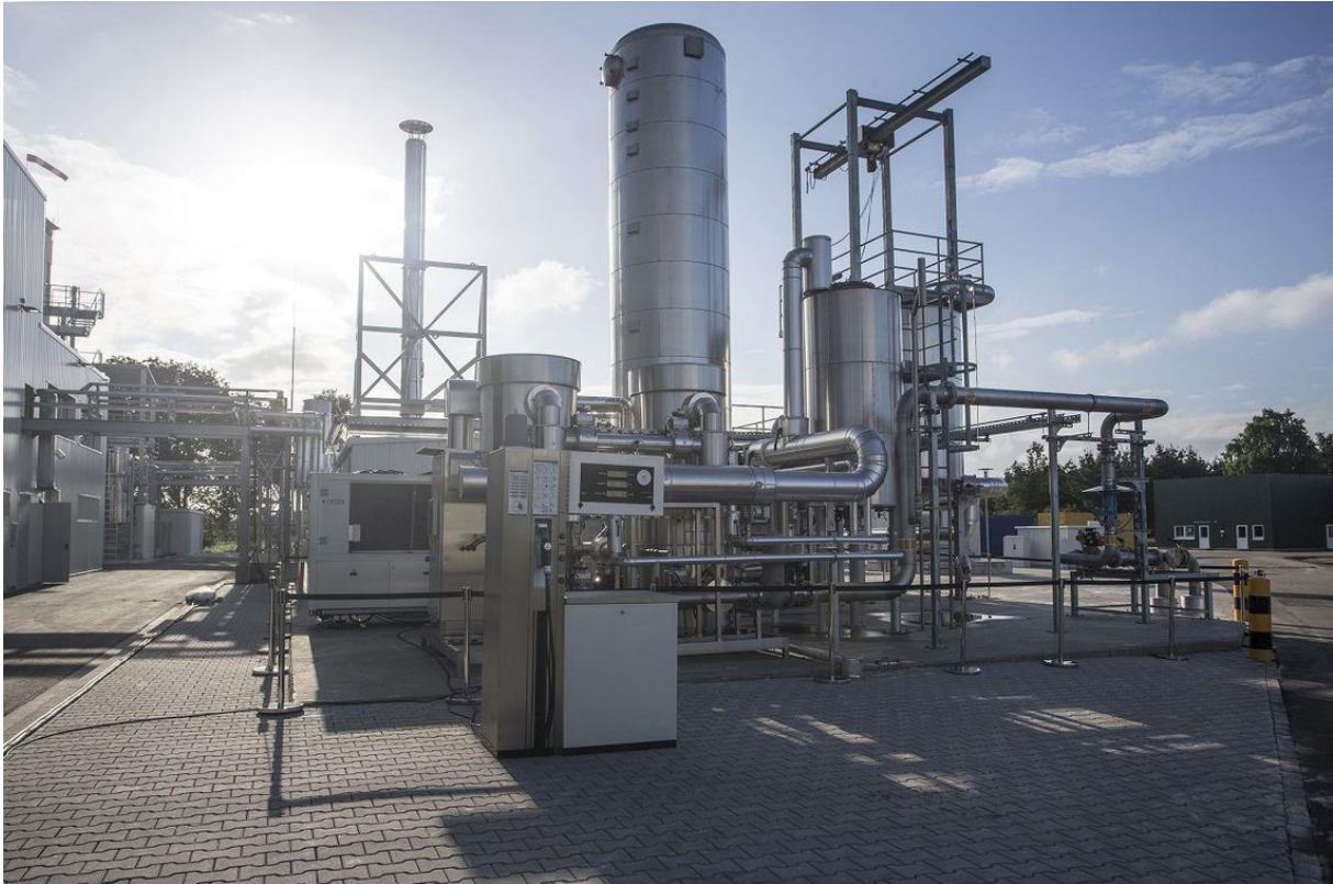
Die Audi e-gas Anlage in Werlte
